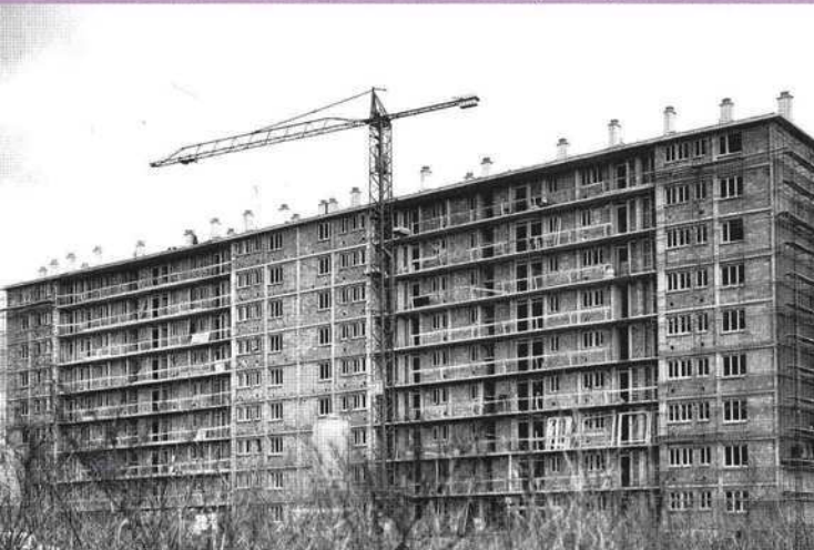
Immeuble HLM en construction (1961).
